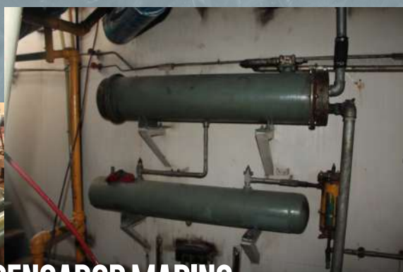
CONDENSADOR MARINO INSTALADO EN EL ASTILLERO CONSTRUCTURA Y REPARADORA DE BUQUES EN BARCO DE LA SERIE MAROS
