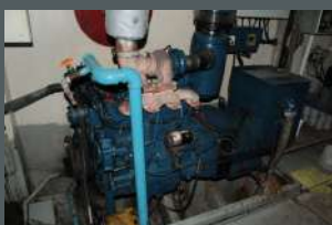
MANTENIMIENTO E INSTALACIÓN DE MOTORES
