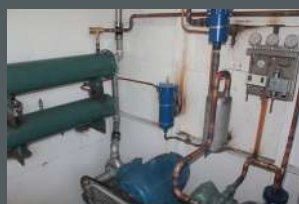
MANTENIMIENTO E INSTALACIÓN DE EQUIPOS DE REFRIGERACIÓN
