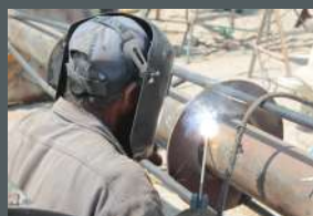
SOLDADURA Y CAMBIOS DE PLACA DE ACERO
